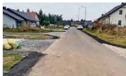
» Nowa droga wewnętrzna w Miroszowicach.
