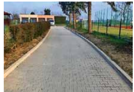
» Remont przy szkole w Siedlcach.
