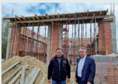
» W trakcie inwestycji.
