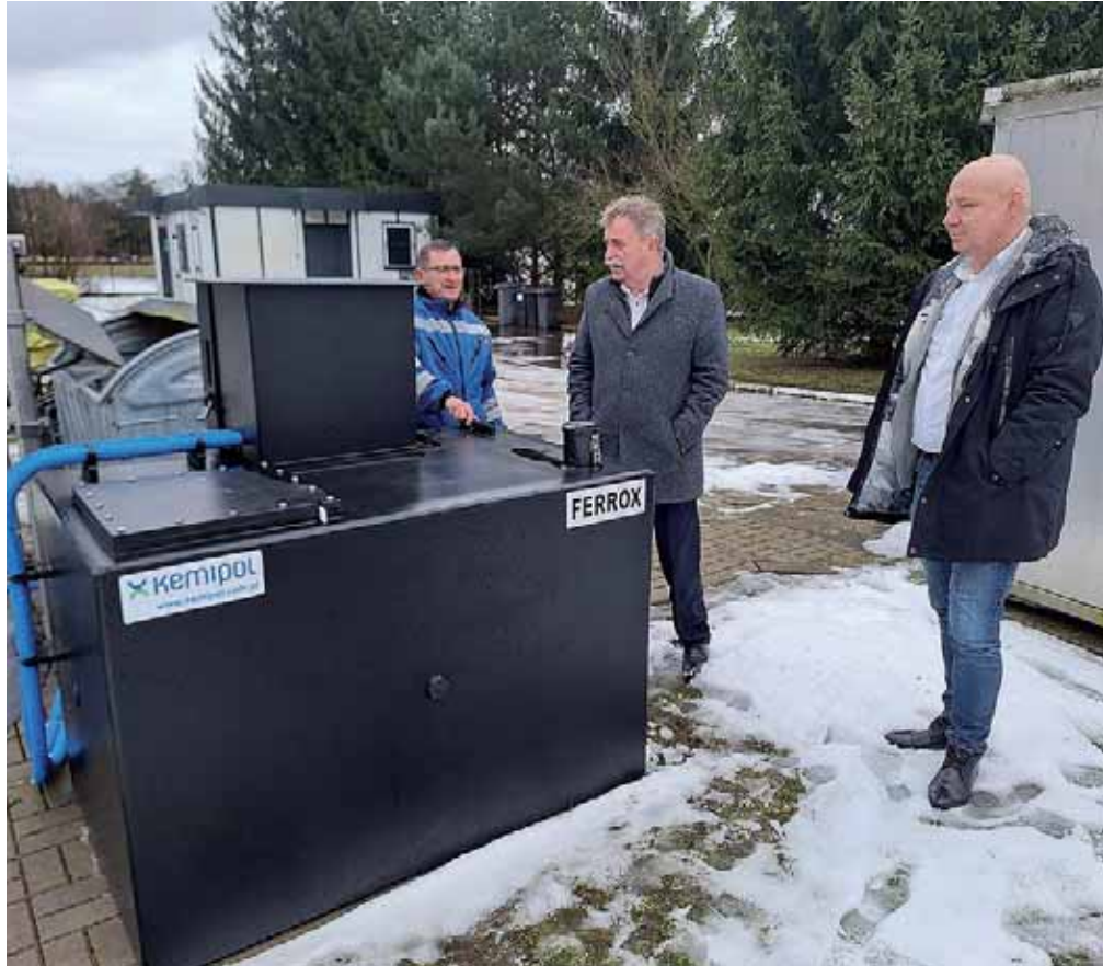
» Instalacja dozowania substancji antyodorowych
