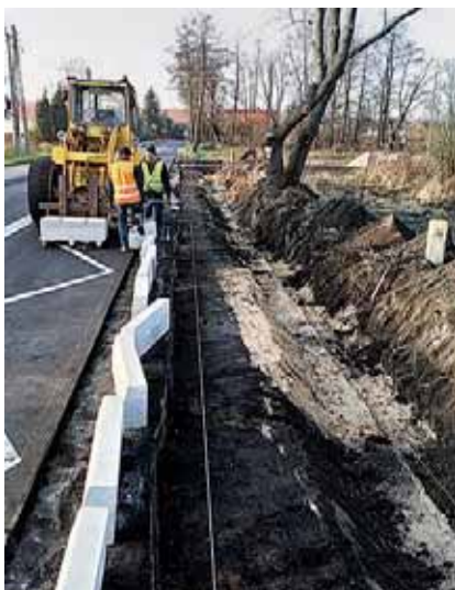
» Budowa chodnika przy drodze wojewódzkiej w Krzeczynie Małym
