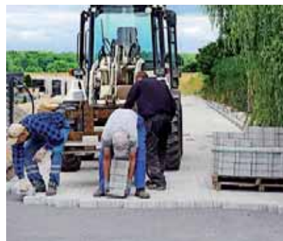
» Budowa drogi wewnętrznej w Niemstowie
